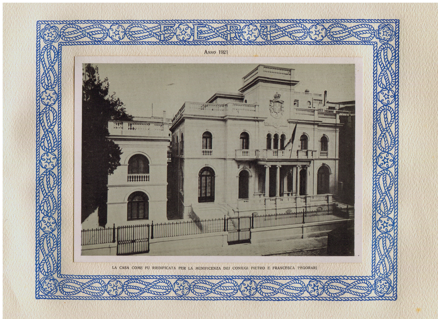
L'edificio di Méndez-Vigo 8 nel 1921: si sono aggiunti i due corpi laterali, è stata creata la loggia centrale ed è stato aggiunto un corpo di fabbrica secondario a sinistra del principale. La facciata è considerevolmente modificata rispetto all'originale
